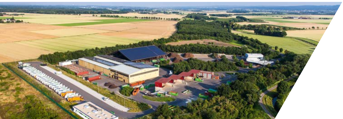
RSAG-Entsorgungsanlage in Swisttal-Miel mit Kompostwerk
