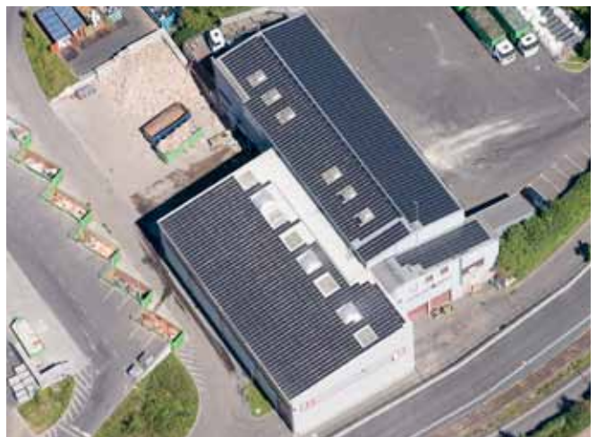
Fotovoltaikanlage ESA Troisdorf
